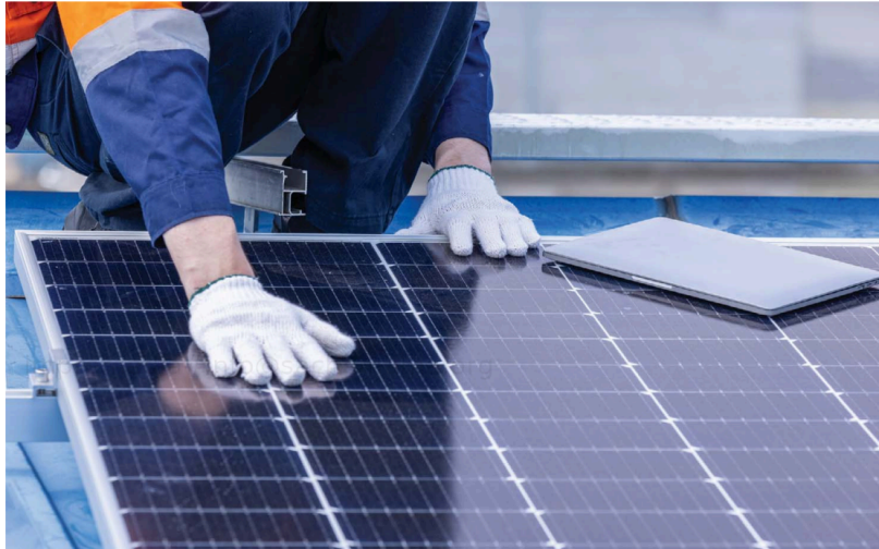
Hay oportunidades en trabajos como la colocación de paneles solares./SHUTTERSTOCK
